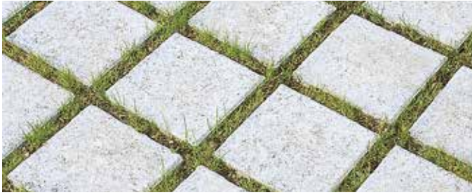
Versickerung durch aufgeweitete Fugen (Rasenfuge)
