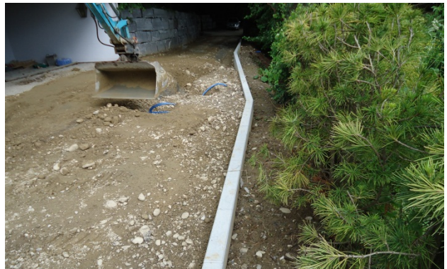
Bild 29: Lagenweises Einbringen von geeignetem Hinterfüllmaterial
