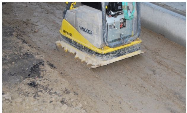
Bild 30: Verdichten nur mit sehr leichten Verdichtungsgeräten
