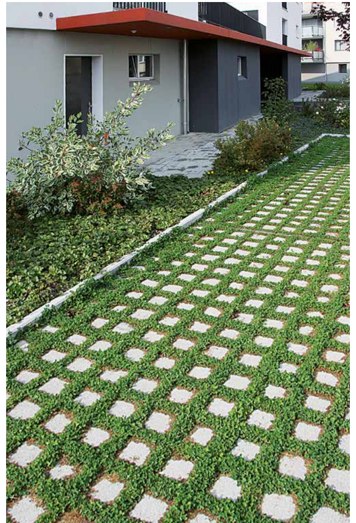
Parkfläche mit CLASSIC® Rasenfuge
