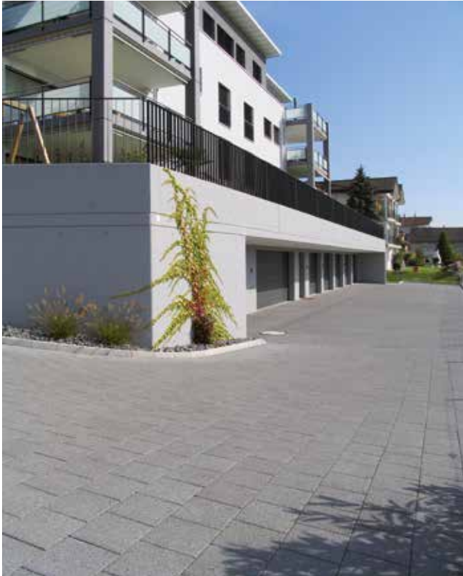
Versickerung durch Sickerstein
