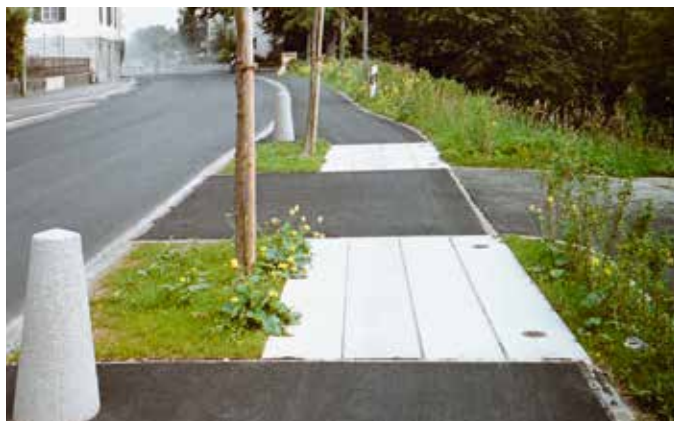
Wurzelbrücke mit Wehrsteinen als Anfahrtschutz
