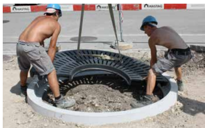
Versetzen der Gussroste
