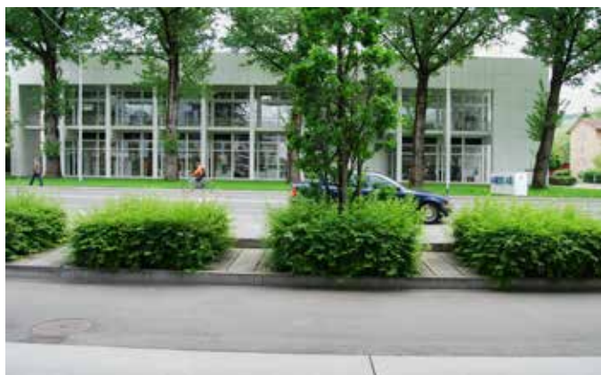
Einbau von Verbindungen zwischen den Baumgruben
