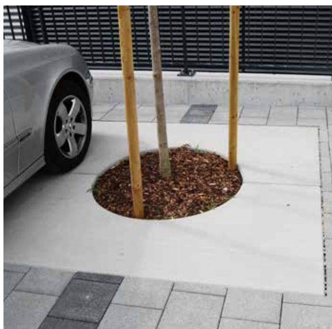
BAUMFIX® Baumscheiben in Pflastersteinfläche
