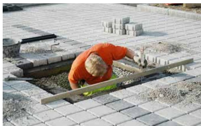
Erstellen eines Auflagers auf Fundamentrahmen
