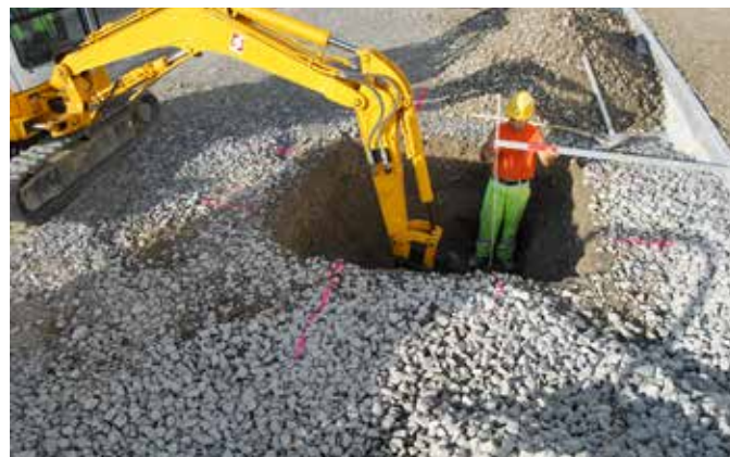
Erstellen des Pflanzloches
