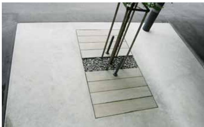
Einbau von Baumgruben mit einer Fläche von > 6 m 2
