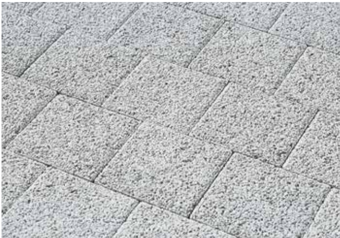
Wasserdurchlässiger Pflasterstein (Sickerstein)
