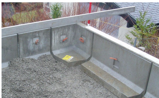
Bild 38: Versetztes Eckelement
