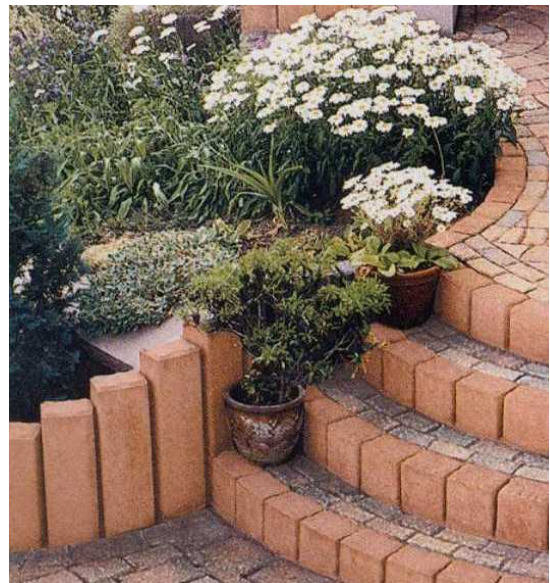
Bild 4: Abtreppungen mit rechteckigen Palisaden
