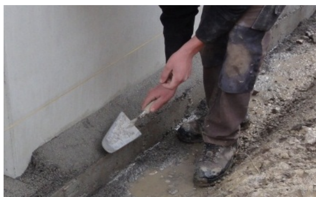
Bild 24: Erstellen der Fundamentnocken
