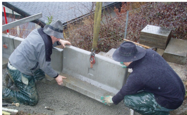
Bild 23: Versetzen der Winkelplatte auf ein Streifenfundament
