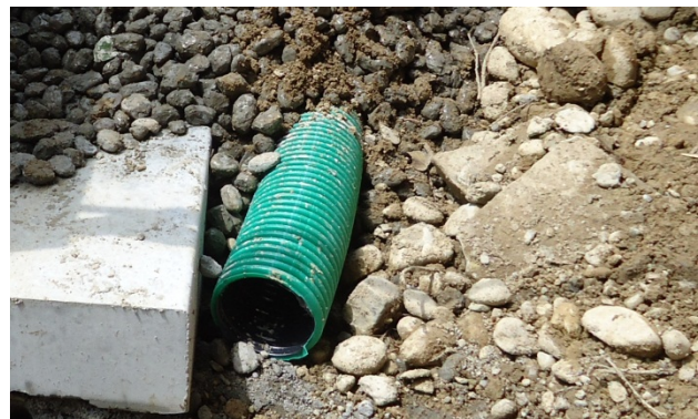
Bild 22: Einbau einer Sickerleitung
