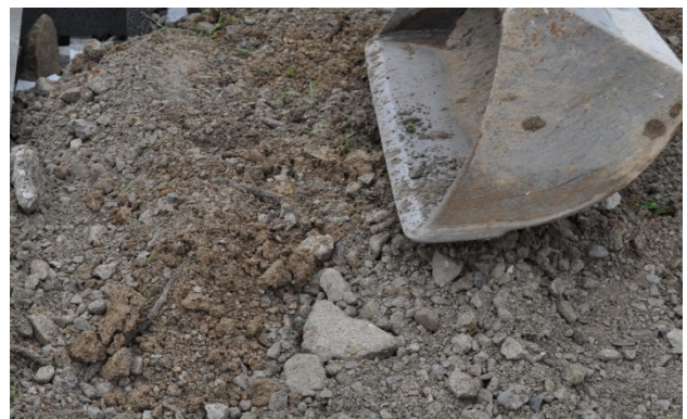
Bild 28: Lagenweises Einbringen von geeignetem Hinterfüllmaterial
