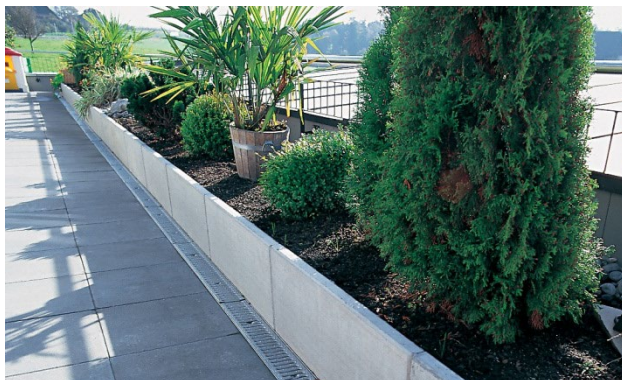
Bild 1: ROZTEC® MINI Winkelplatten als Böschungssicherung
