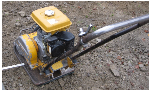
Bild 29: Verdichten nur mit sehr leichten Verdichtungsgeräten
