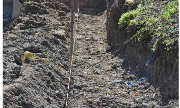
Bild 19: Aushub auf Frosttiefe
