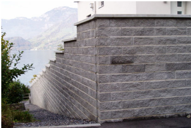
Bild 1: Spaltsteine, eingesetzt als Hangsicherung
