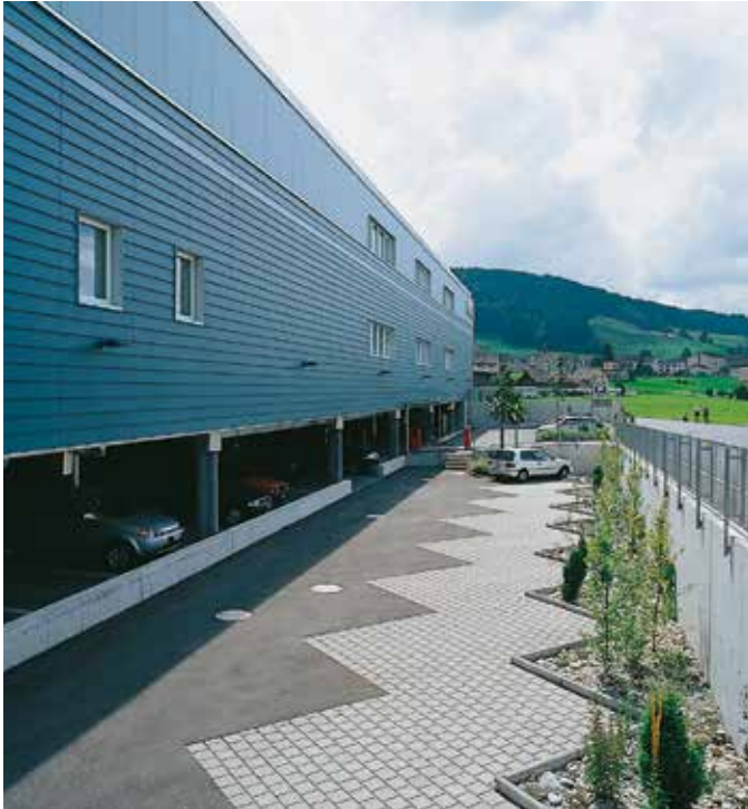
Versiegelte Fläche, kombiniert mit Versickerung
