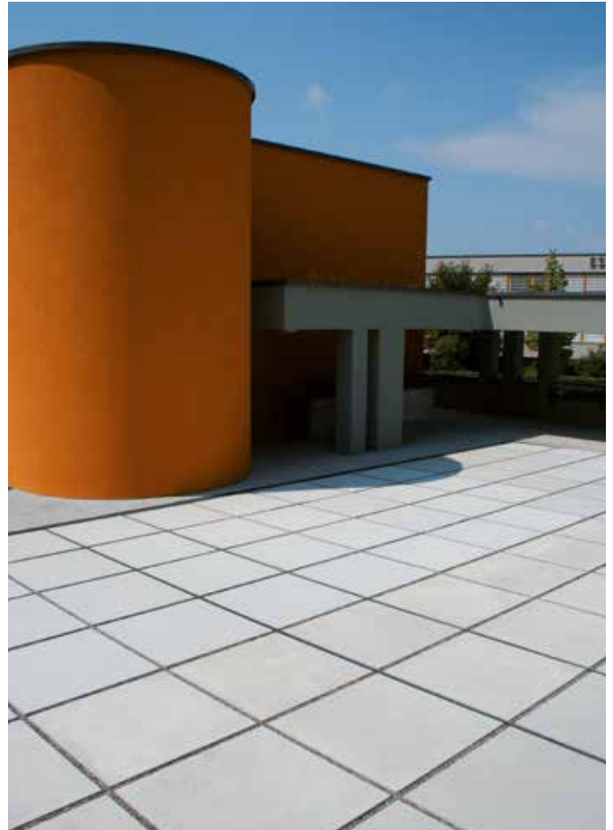
Optische Raumerweiterung mit grossflächigen Platten
