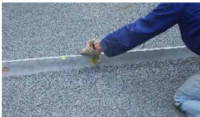
Nivellement du lit de pose
