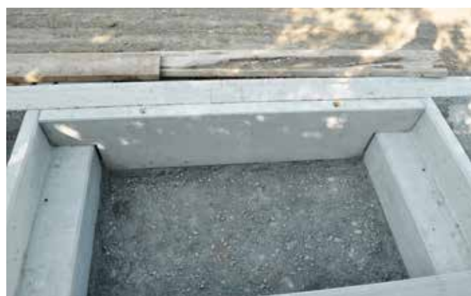
Versetztes F+F Abschlüsselement
