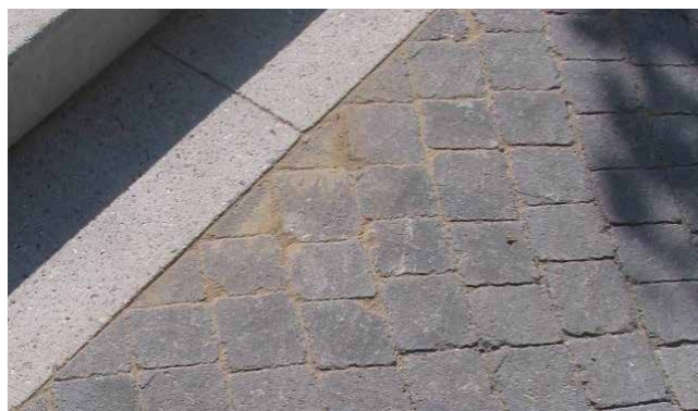
Surface pavée avec pierres d'ajustage
