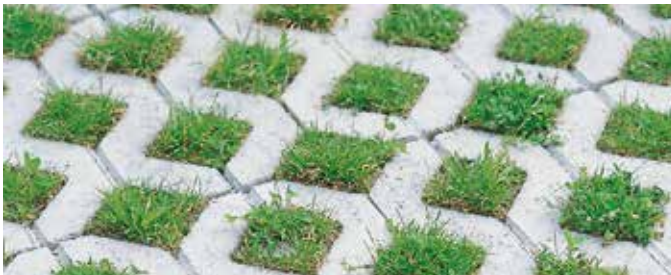
Versickerung durch eingelassene Kammern (Rasengittersteine)
