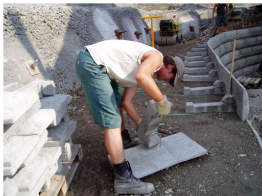
Bild 15: Frontplatte mit Anker verbinden
