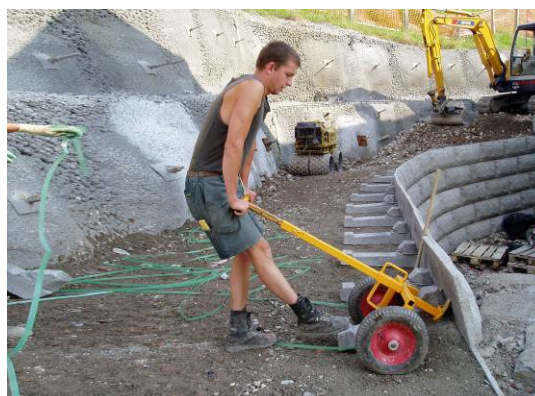
Bild 17: LOCK+LOAD Versetzwagen
