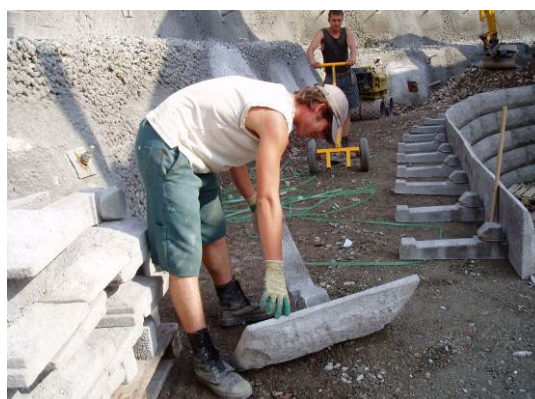
Bild 16: Frontplatte mit Anker verbinden
