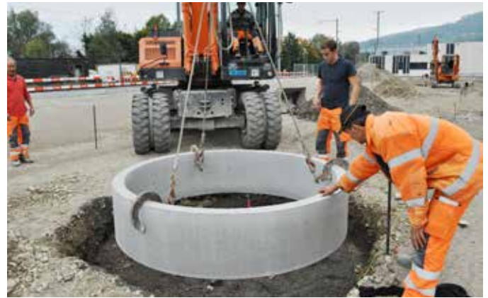
Versetzen des TREETUB Betonrohres auf das Streifenfundament
