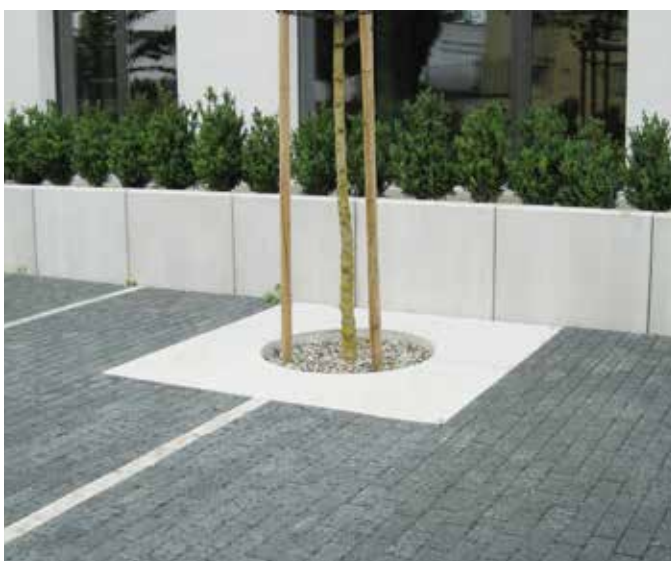
ROZTEC® Winkelplatten für Hochborde
