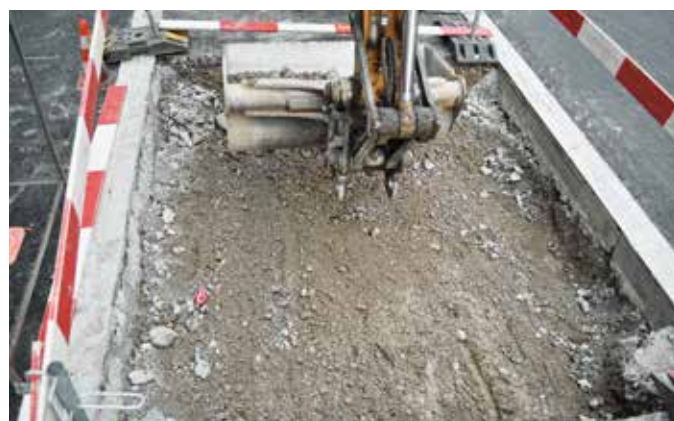
Erstellen der Sohle für den Fundamentrahmen
