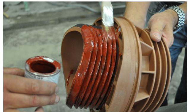
Bild 9: Auftragen von DENSONOX GV auf Dichtungsmanschette
