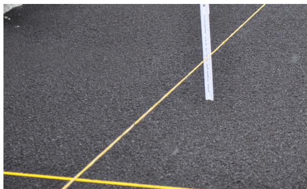
Bild 22: Kontrolle der Einbauhöhe
