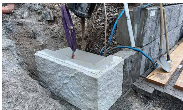
Illustration 22 : briques initiales avec semelle filante sans mortier-colle
