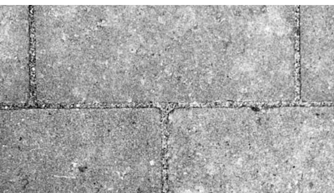
Wirksame Pflasterdecke durch funktionsfähige Fugen
