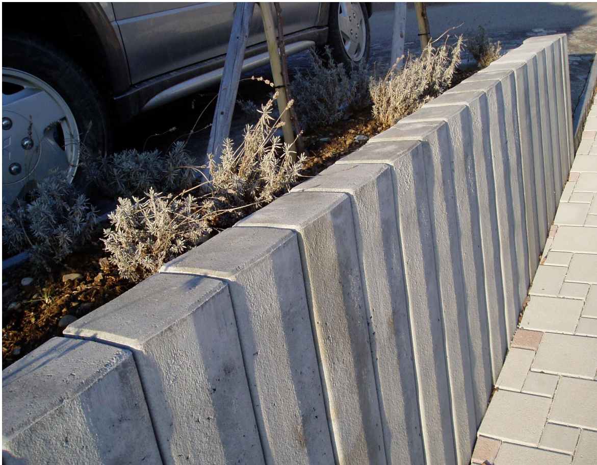
Bild 1: Betonhohlpalisade rechteckig
