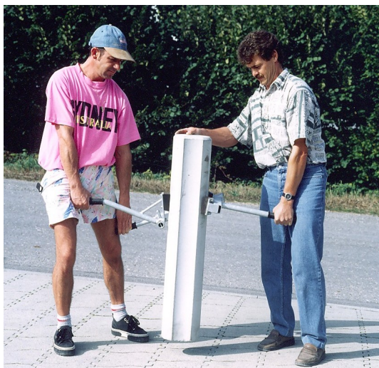
Bild 6: Transport mit Versetzzange
