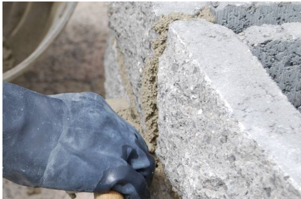
Bild 46: Modellieren der Fuge
