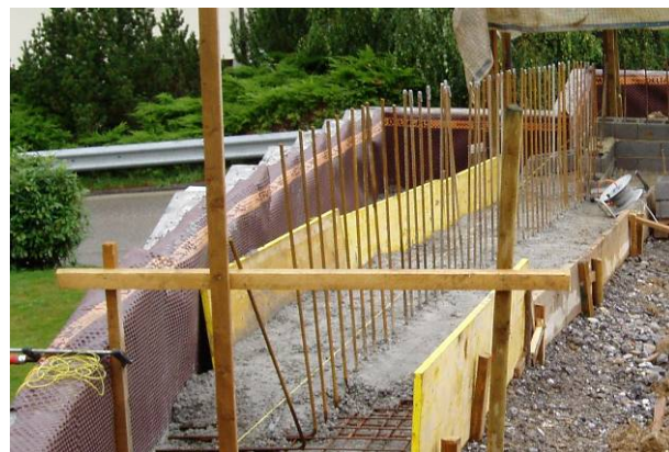
Bild 35: Fundament mit Anschlussbewehrung
