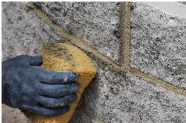
Bild 48: Aufräumen der Fugenfüllung und reinigen der Bausteine
