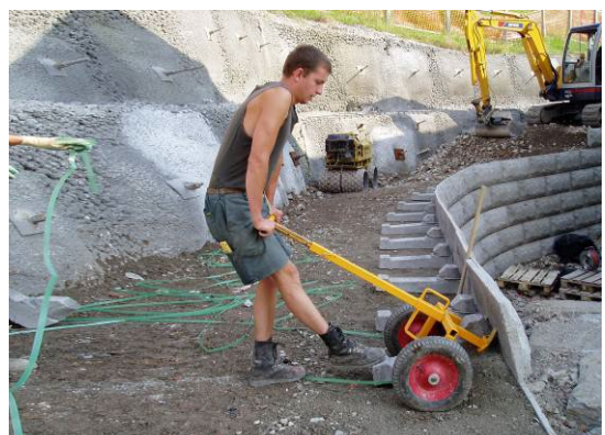
Bild 17: LOCK+LOAD Versetzwagen
