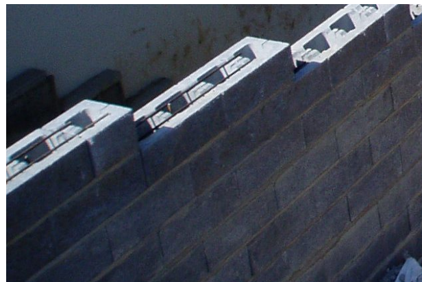
Bild 49: Bewehrungseinlagen, eingelegt in die vorgesehene Nuten
