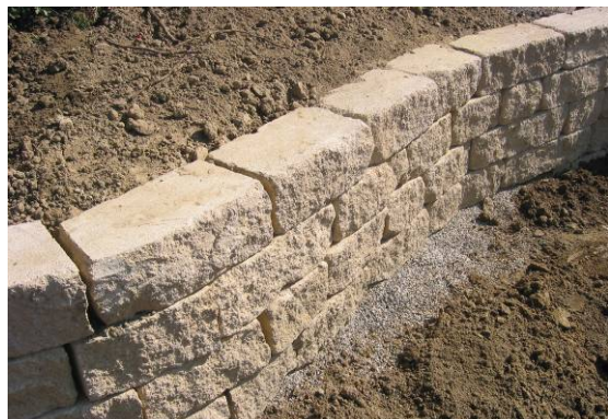
Bild 28: Kurvengbildung mit geraden Steinen
