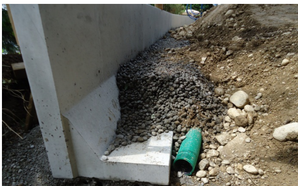
Bild 24: Einbau einer Sickerleitung
