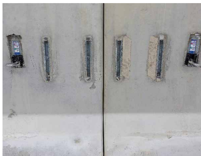
Rails Halfen comme système d'assemblage
