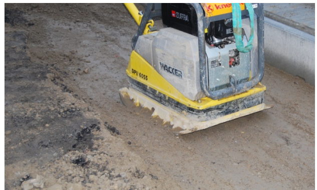
Bild 35: Verdichten nur mit leichten Verdichtungsgeräten
