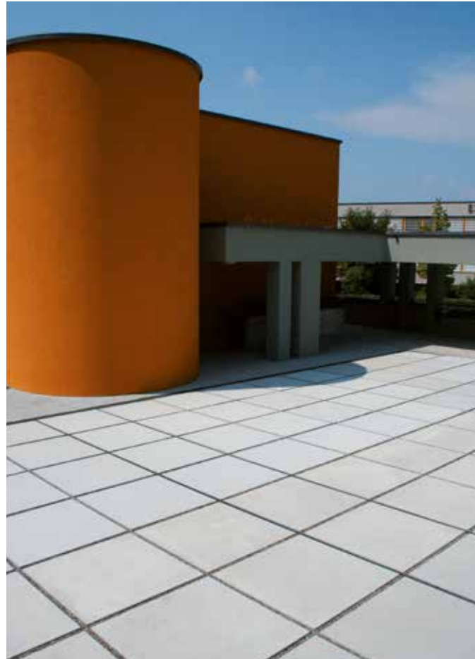
Optische Raumerweiterung mit grossflächigen Platten
