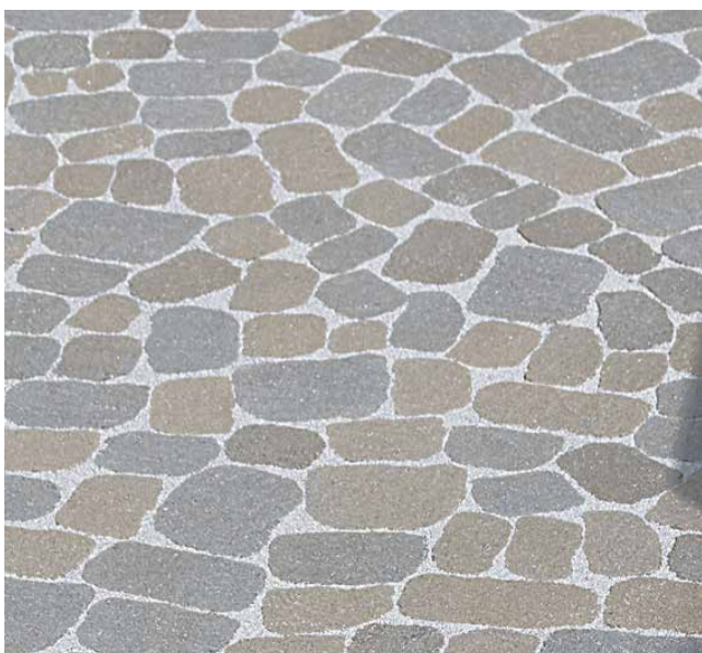
Remplissage des joints avec des mortiers à base de résine époxy (par exemple ROMPOX® DRAIN ou D1)
