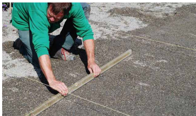
Nivellement du lit de pose
