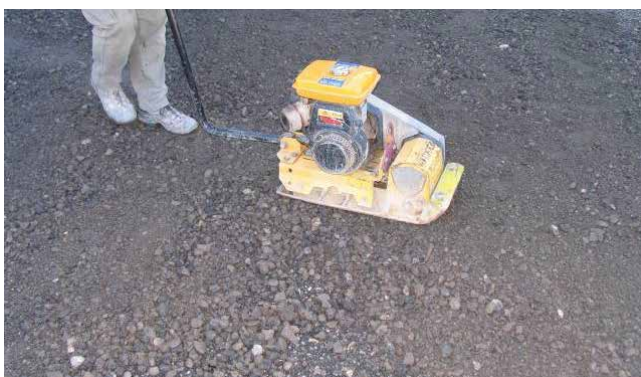
Compactage de la couche de fondation
