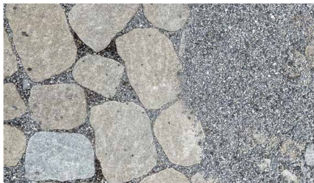
Sablage/gravillonnage des joints
