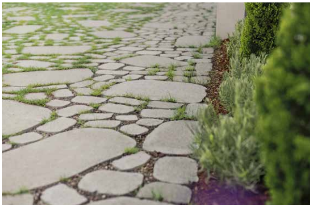
Remplissage des joints avec des gravillons, un mélange de sable et de gravillons, ou un substrat
