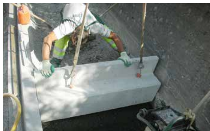
Versetzen des F+F Fertigfundamentes
