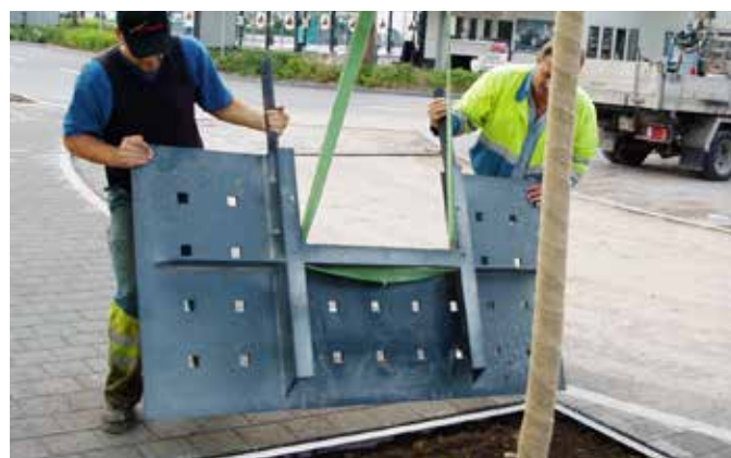
Transport der COPAL STEEL Stahlbaumscheibe
