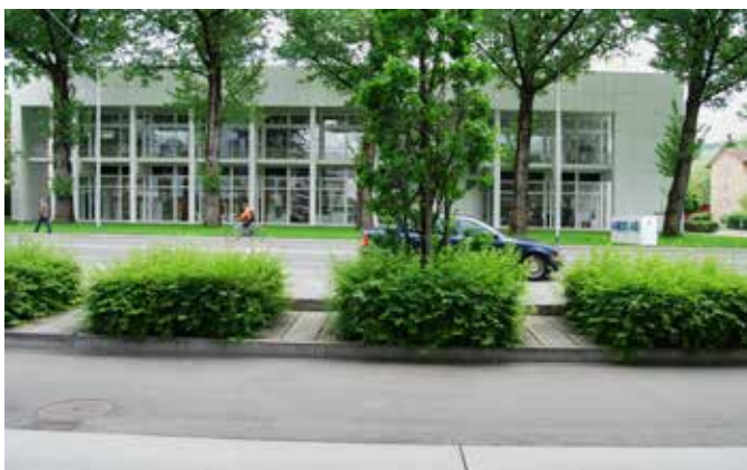
Einbau von Verbindungen zwischen den Baumgruben
