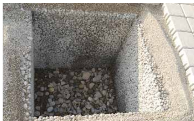
Erstellter Fundamentrahmen
