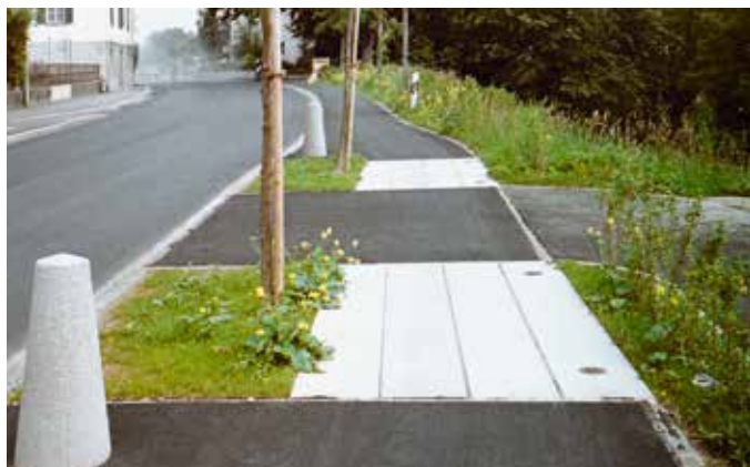
Wurzelbrücke mit Wehrsteinen als Anfahrtschutz
