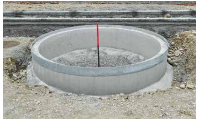
Montierter Stahlleinbaurahmen mit Bolzenanker
