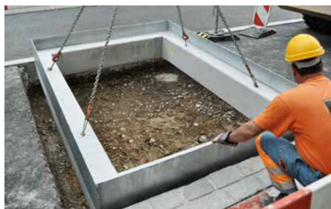
Versetzen des BAUMFIX® Kombirahmenelementes
