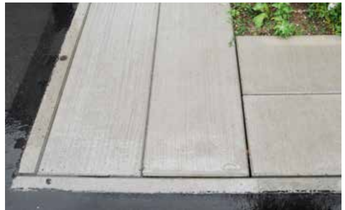
Wasserzufuhr durch Fugen
