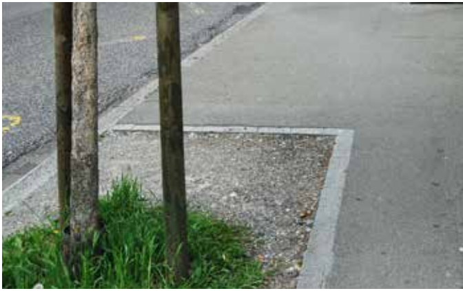
Ungeschützter Wurzelraum führt zu hoher Bodenverdichtung
