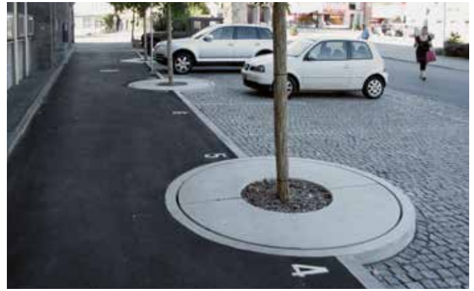
Anlegen von Hochborden
