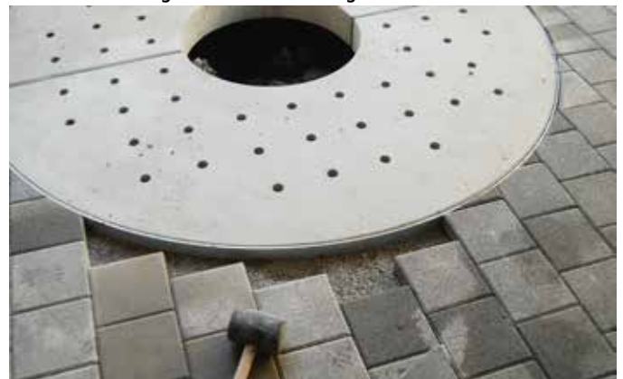
Versetzte TREETUB Betonabdeckung 2-teilig
