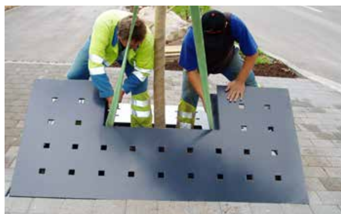
Versetzen der COPAL STEEL Stahlbaumscheibe
