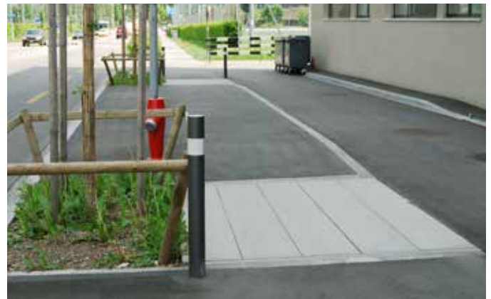
Einbau von Wurzelbrücken seitlich der Baumgrube
