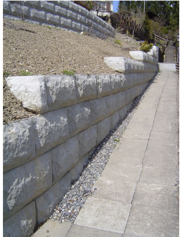
Bild 47: seitlicher Abschluss der Abtreppungen mit Ecksteine
