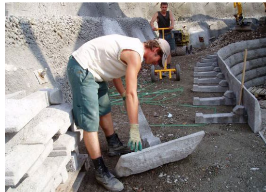
Bild 16: Frontplatte mit Anker verbinden
