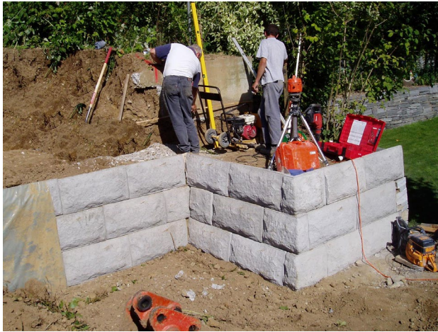
Bild 45: Innenecke mit Gehrungsschnitt und Aussenecke
