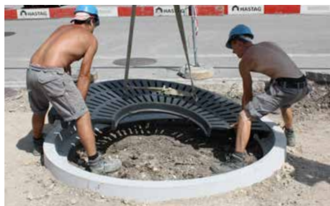
Versetzen der Gussroste
