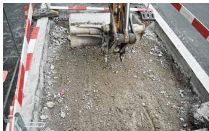
Erstellen der Sohle für den Fundamentrahmen
