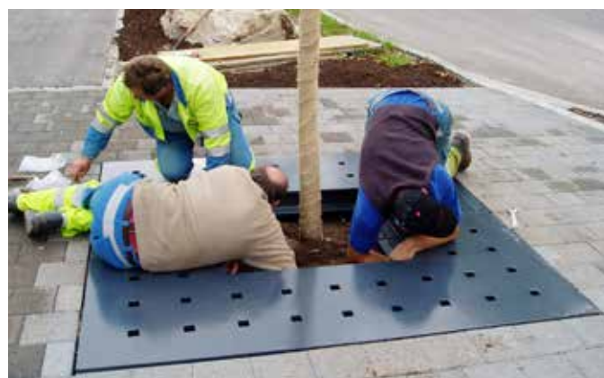
Montieren der Verbindungsschrauben
