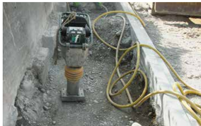
Sohle für die Versetzung der Fundamente
