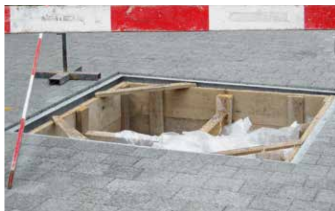
Pflanzgrube mit Fundament und Stahlrahmen
