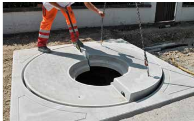
Versetzen der COPAL Betonabdeckung
