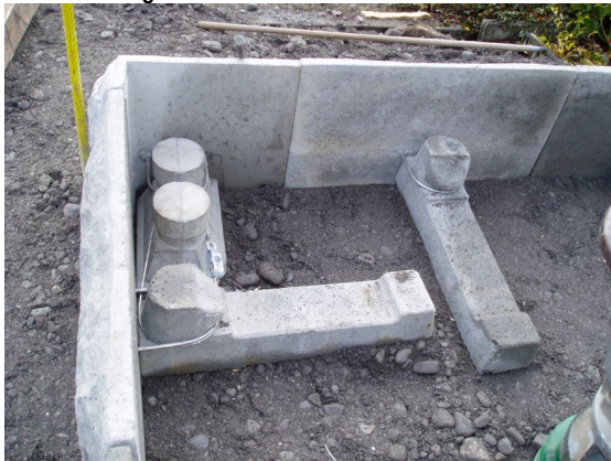
Bild 39: Eckstein mit Eckanker und -spanner
