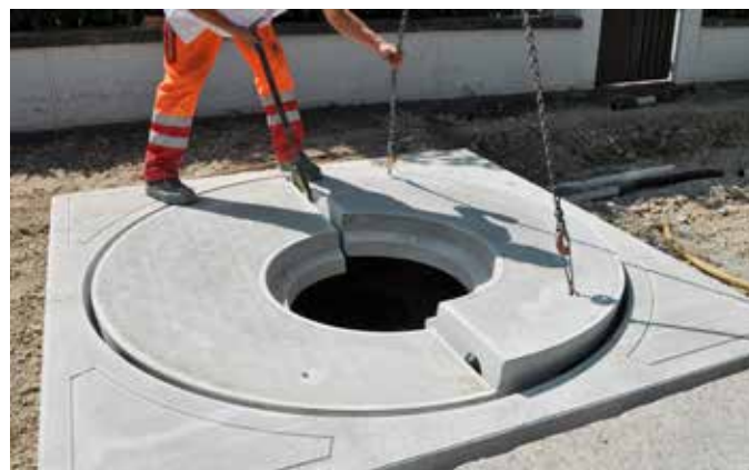
Versetzen der COPAL Betonabdeckung
