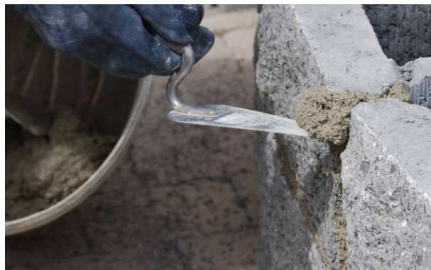
Bild 45: Entfernen von überschüssigem Mörtel
