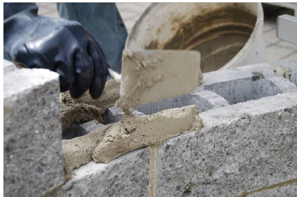
Bild 42: Aufbringen der Mörtelschicht
