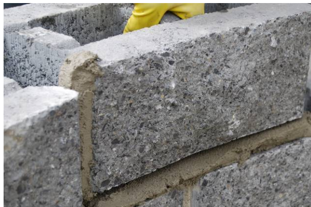
Bild 43: Versetzen des Mauersteines auf die Mörtelschicht
