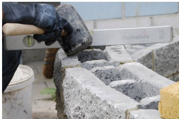
Bild 44: Richten und anklopfen des versetzten Spaltsteines
