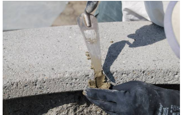
Bild 64: Verfugen der Abdeckplatten
