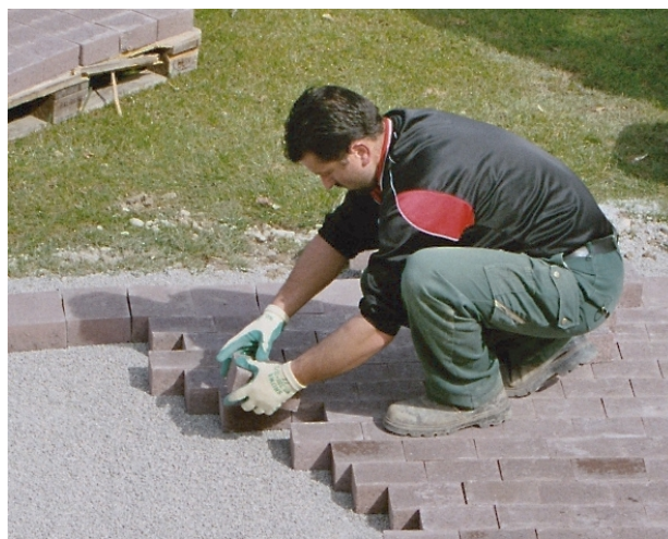
Bild 35: Verlegung der Steine von Hand
