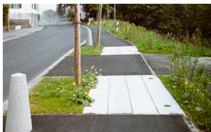
Wurzelbrücke mit Wehrsteinen als Anfahrtschutz
