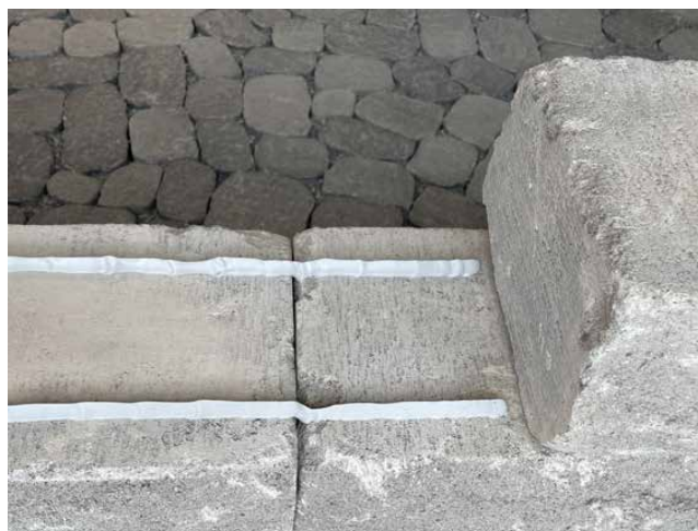
Illustration 1 : Encollage d'une rangée
