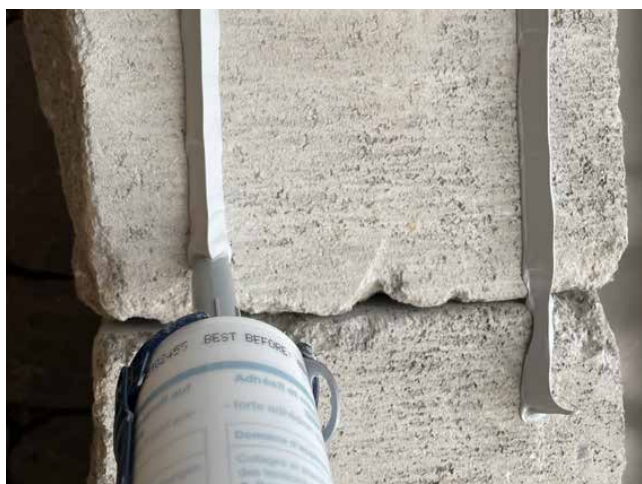
Illustration 3 : Positionnement correct de la buse
