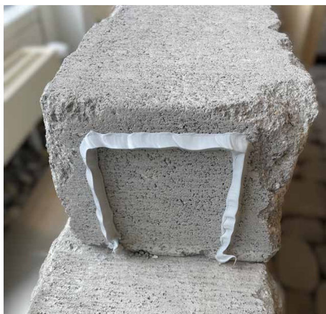
Illustration 2 : Encollage d'une tête de brique
