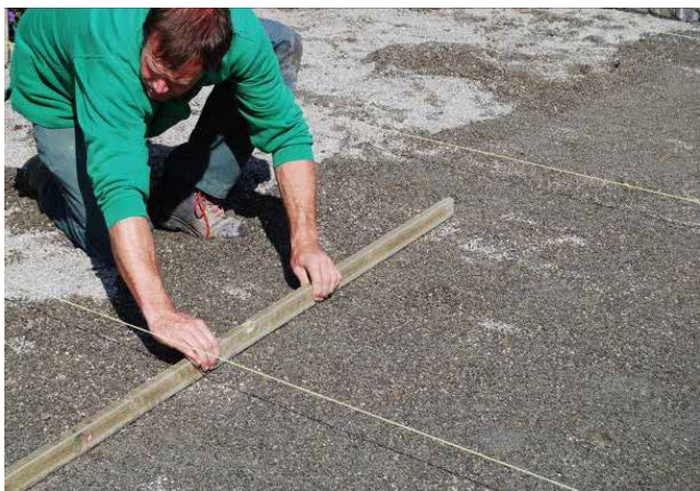
Réglage du lit de pose
