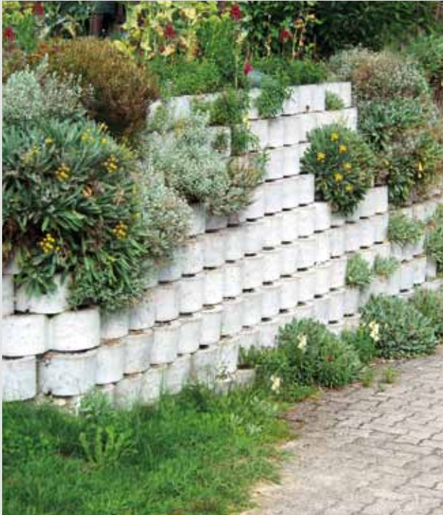
Begrünbare (offene) Hangsicherung
