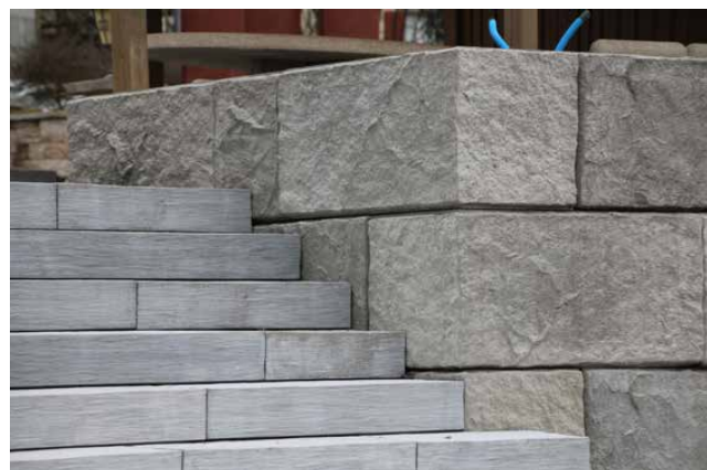
Illustration 2 : éléments de talus FELSMAUER pour la consolidation de talus
