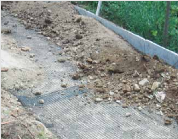
Verlegtes Geogitter
