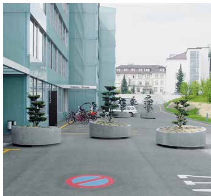
Betonrohre als Randeinfassung
