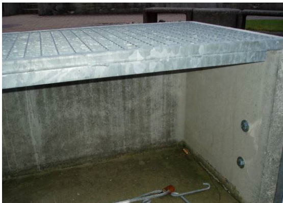
Bild 39: Verstärkte Gitterrostkante gegen die Hauswand
