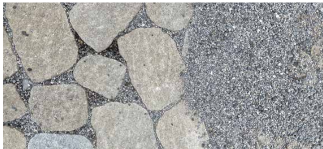
Remplissage des joints
