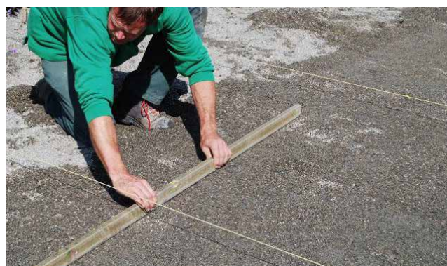
Réglage du lit de pose
