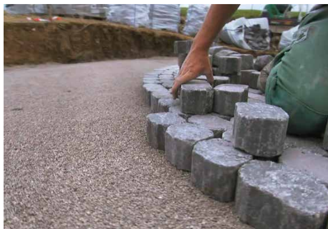
Les pavés ARENA Vista® sont posés à la main.
