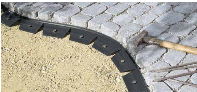
Bordure latérale avec le profil PAVE EDGE®
