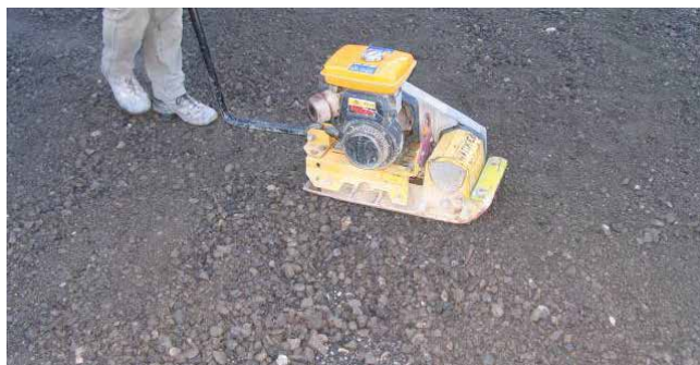
Compactage de la couche de fondation
